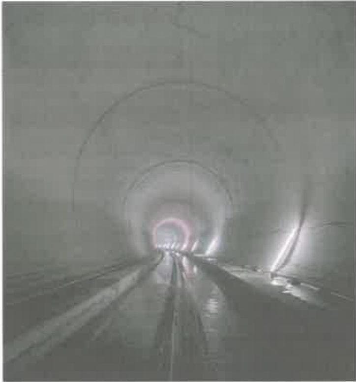
Mit seinen Bildern eröffnet Gregor Sailer Zugänge zu nur schwer erreichbaren Orten wie der Baustelle im Brenner-Basis-Tunnel.
